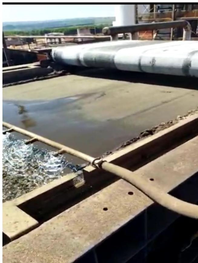
Figura 16: Análise visual da secagem da torta de filtro (In: Planta Industrial, 2023).
