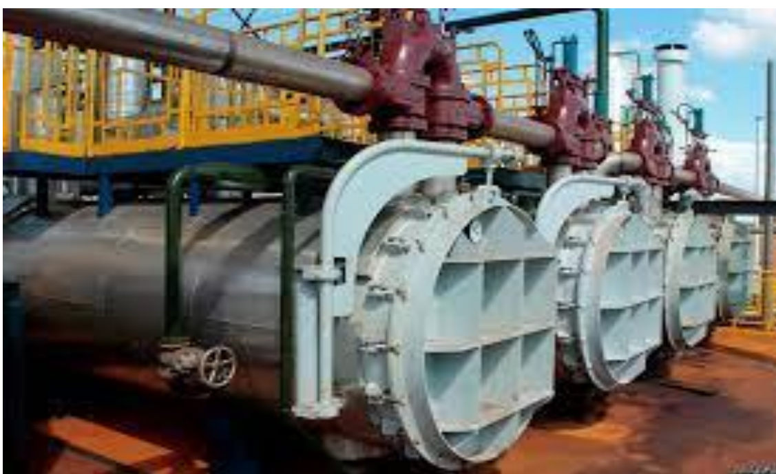
Figura 6: Aquecedor tubular horizontal (In: Planta Industrial, 2023).
