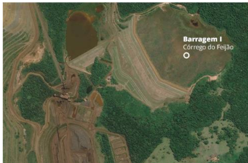
Figura 1: Antes do rompimento
