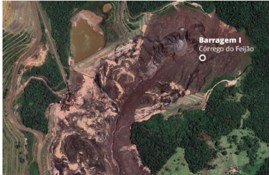
Figura 2: Depois do rompimento
