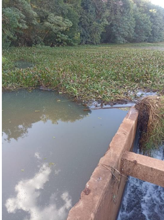
Figura 5: Montante do córrego Água Bonita.
