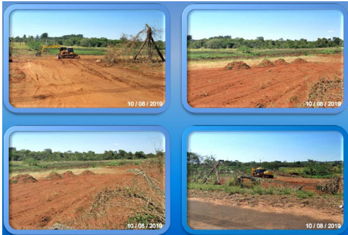
Figura 28: Imagem da área da APP sem a cobertura vegetal
