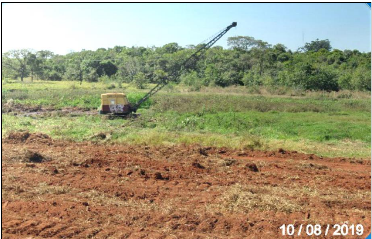
Figura 25: Imagem da máquina usada para o desassoreamento da APP
