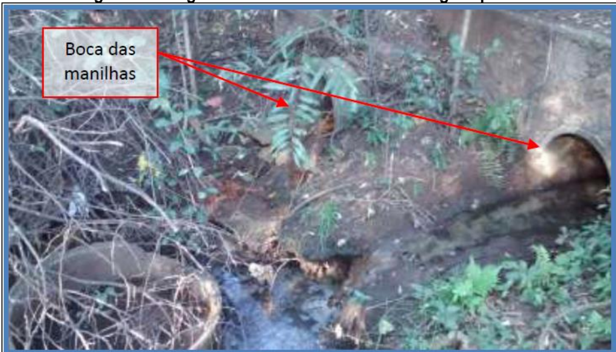
Figura 13: Imagem das bocas das manilhas de águas pluviais
