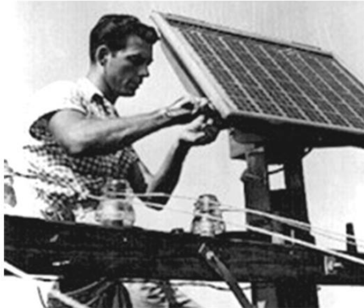
Figura 4: A primeira aplicação de uma célula solar de silício (Fonte: VALLÊRA; BRITO, 2006)
