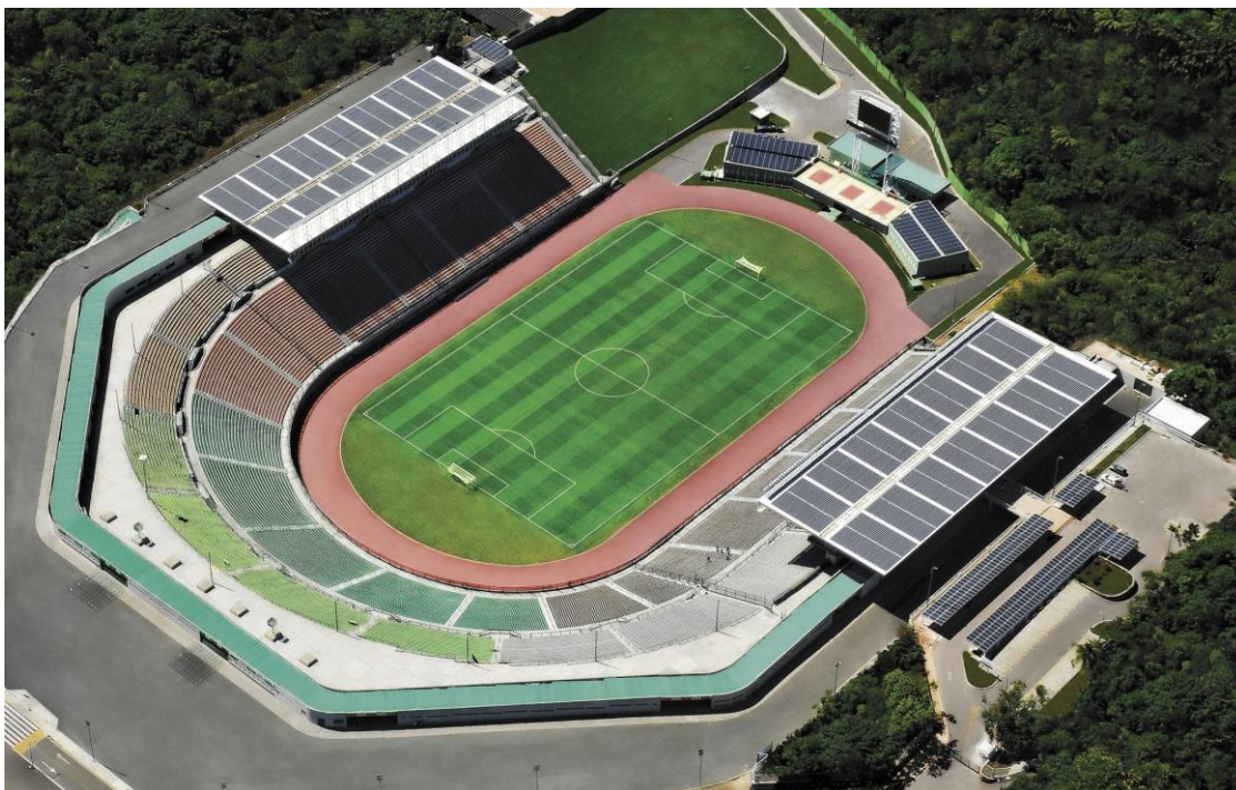
Figura 6: Estádio Pituvaçu - Salvador/BA (Fonte: GREENBRAS, 2019)
