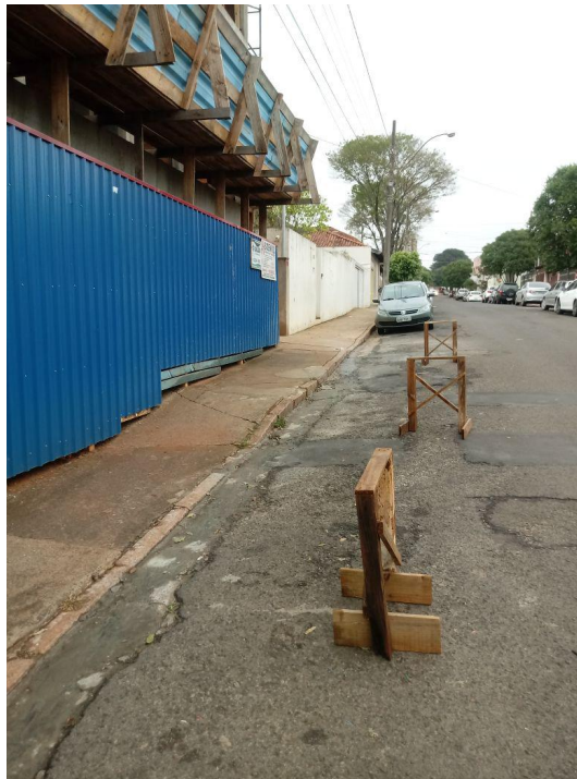
Imagem nº 22 – Rua Drª Ana Barbosa defronte ao nº 500 / Tirada em 17/08/2017
