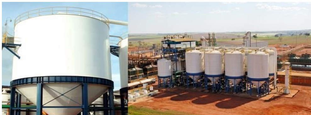
Figura 12: Dornas utilizadas na fermentação alcoólica (In: www.sermatec.com.br )
