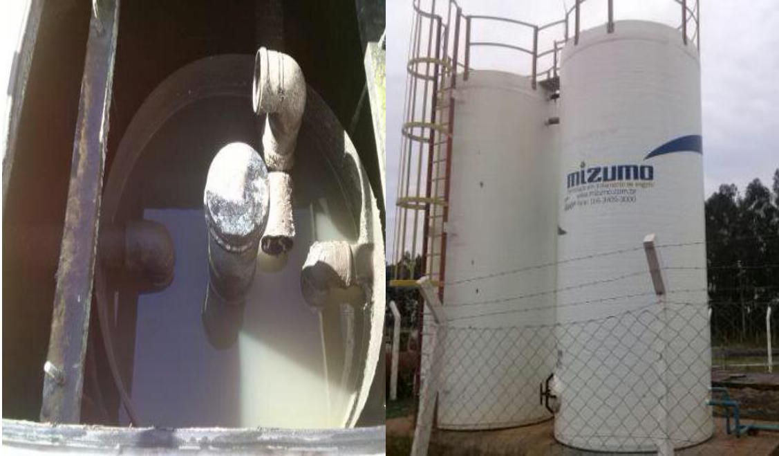
Figura 11: Sistema de tratamento de lodo sanitário da empresa.
