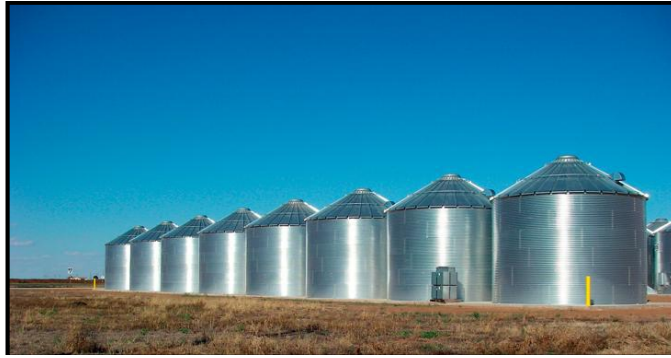
Figura 12 - Bateria de silos verticais em chapa metálica com fundo plano. (In: PATURCA, 2014, p. 11).
