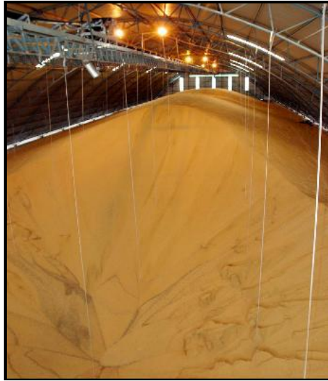
Figura 15 - Interior de armazém fundo "V" com detalhes dos cabos do sistema de termometria. (In: PATURCA, 2014, p. 14).
