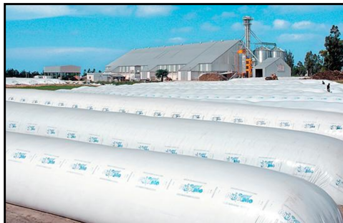
Figura 16 - Silos Bolsas (In: PATURCA, 2014, p.17)
