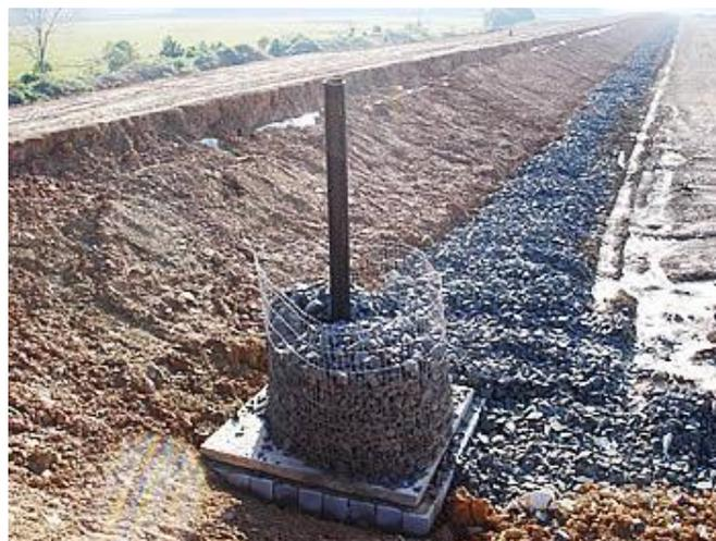
**Figura 12 – Esquema de captura e queima dos gases gerados no aterro (In: SANTEC, 2014).**
