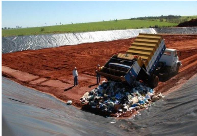
**Figura 2 - Modelo de um aterro em trincheira (In: KAWA, 2014)**
