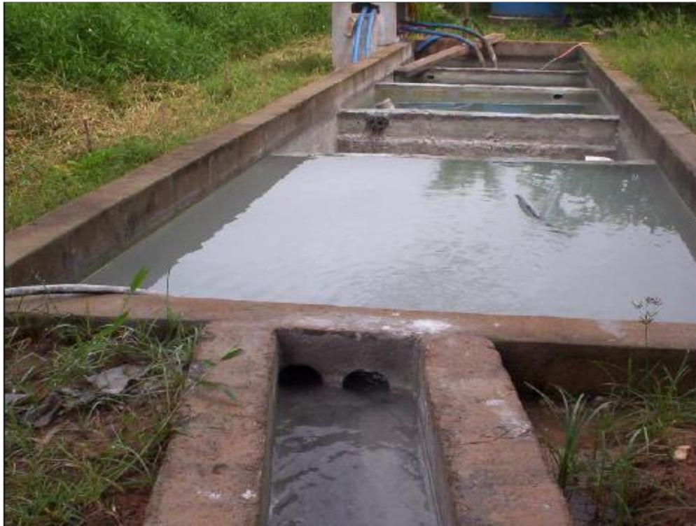
**Figura 4: Sistema típico de sucessivos tanques de decantação para a sedimentação dos sólidos dos efluentes (In: TASAÍCO, 2007).**
