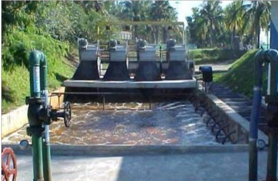
**Figura 5: Flotação por injeção de Ar (In: BERGER, 2012).**
