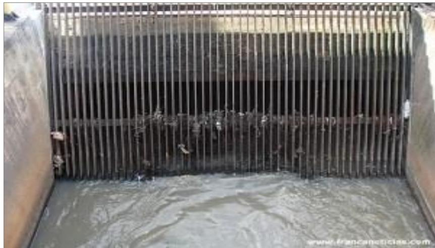
**Figura 2: Grade de contenção de uma estação de tratamento de esgoto (In: FRANCANOTÍCIAS, 2012)**
