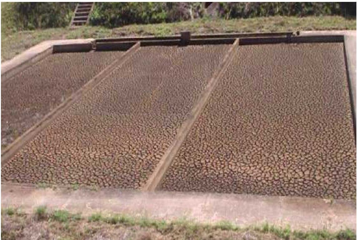
Figura 8 – Leitos de secagem do lodo (In: SANTOS, 2011).
