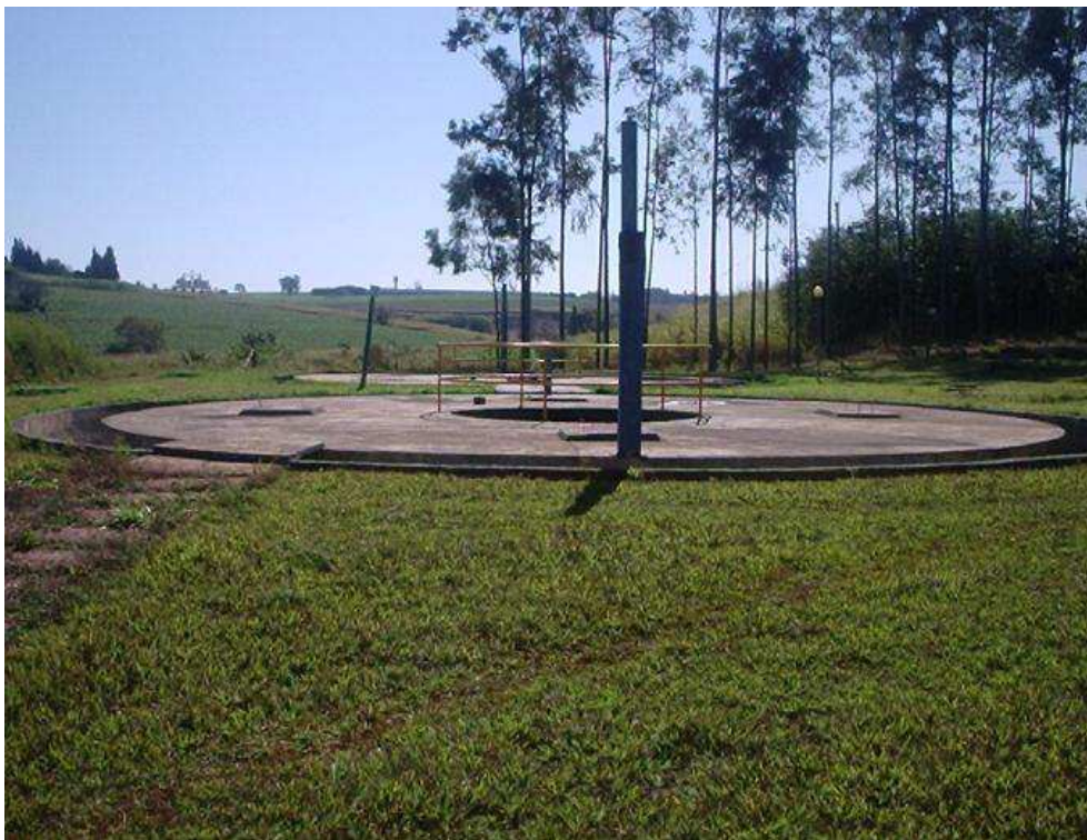
Figura 7 – Reator Anaeróbio (In: SANTOS, 2011).
