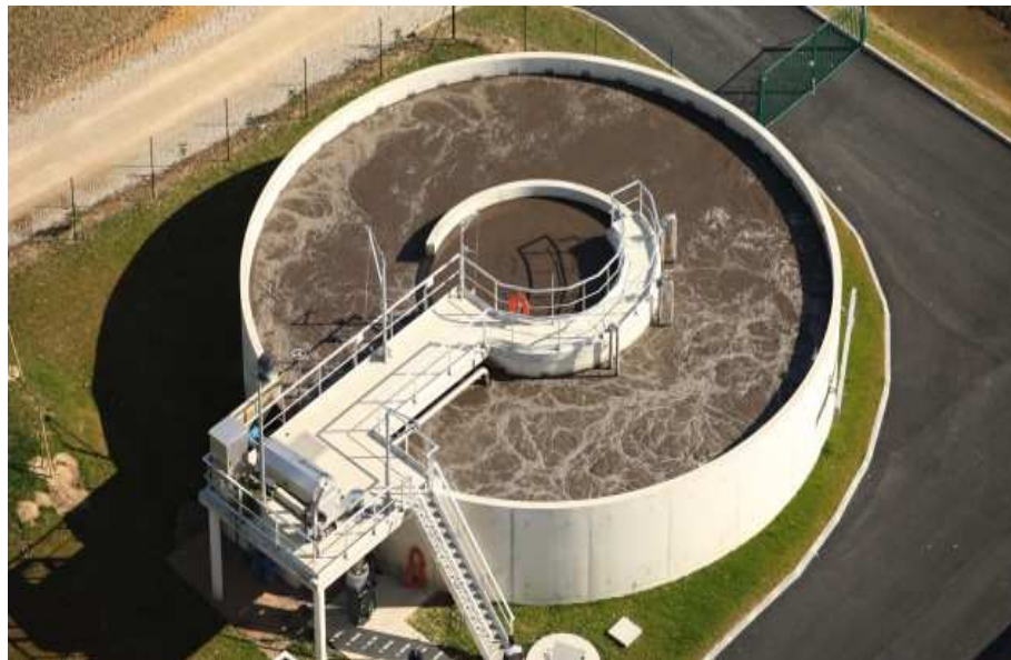
Figura 6 – Reator Aeróbio (Aerador) (In: SANEPAR, 2012).
