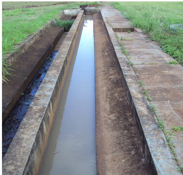
Figura 4 – Desarenador (In: TRATAMENTO DE ESGOTO DE ANDIRÁ-PR, 2012).
