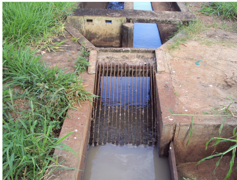
Figura 3 – Grade de retenção. (In: TRATAMENTO DE ESGOTO DE ANDIRÁ-PR, 2012).
