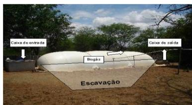
Figura 2 – Modelo Manta de PVC (In: LEME, 2007).
