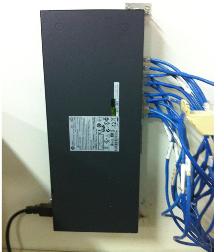
Figura 26 – Switch 3Com 3CRBSG2093 responsável pela distribuição da Internet aos computadores do laboratório da sala F
