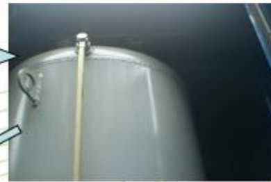
Registro para drenar o ar do cilindro
