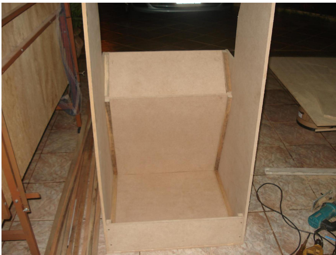
Figura 55 – Base, parte inferior dianteira e traseira e da base do controle prendendo as laterais do gabinete usando sarrafos e parafuso – Vista Traseira
