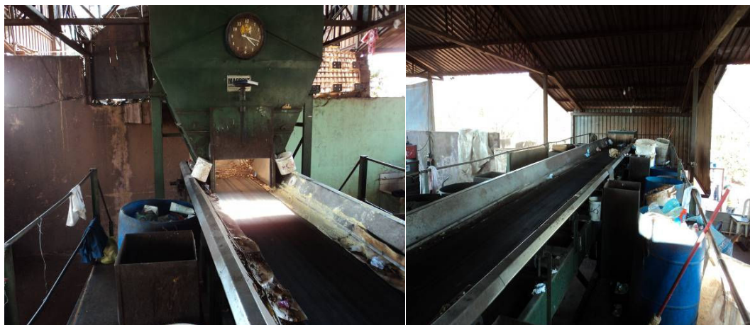
Figura 9 – Esteira de catação da Usina de Reciclagem de Tarumã.
