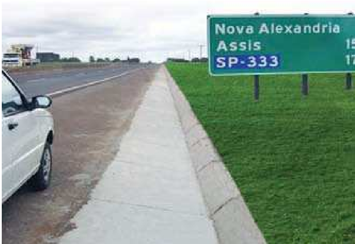
Figura 4 – Canaleta de drenagem (In: Publicação bimestral Caminhos, www.cartsa.com.br/CART/upload/revista/caminhos2_web.pdf )
