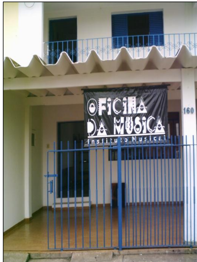
Figura 1 – Fachada da empresa em 20/12/2005
