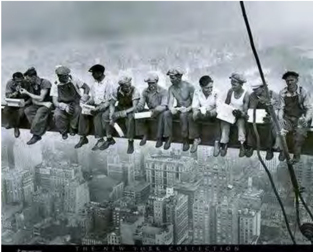
Figura 95 - Nova Iorque Construção Trabalhadores almoçando em um Crossbeam, 1932, Charles Ebbets (fonte: http://mundo-da-fotografia.blogspot.com/2008_08_01_archive.html )
