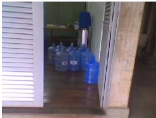
Figura 11 – Local de armazenamento de galões de água impróprio.
