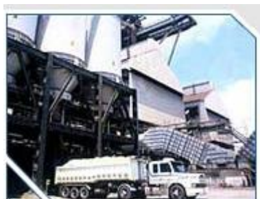
Figura 4 - Granulador de silus de alto forno (In: AcelorMital, 2010).
