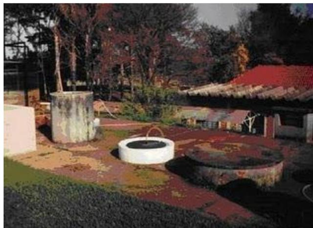
**Figura 05 – Biodigestor modelo chinês (BAGANHA, 2010)**
